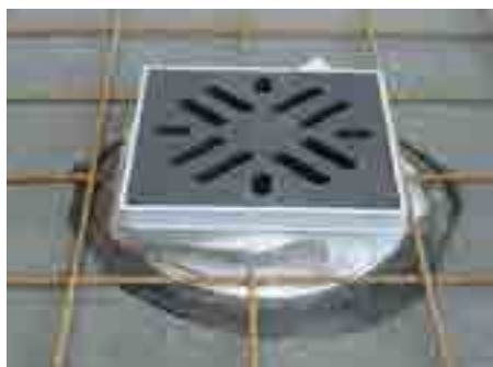
7. Mbulo zgjatuesin me membranë filtrimi, shtro rrjetën e çelikut
