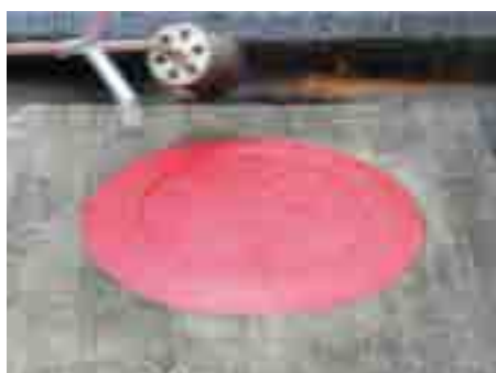
4. Ngjisni shtresën e dytë të bitumit mbi flanaxhën e bitumit
